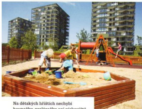
Věžové a terasové domy tvoří elegantně provázaný celek.
